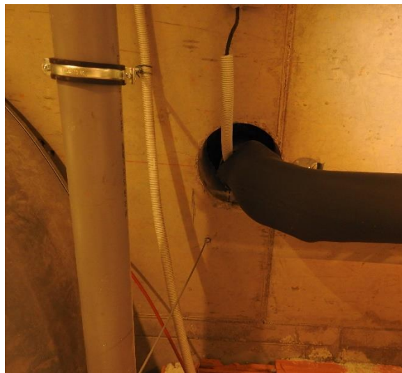
Slika 7: Prikaz kolena vgrajene cevi odtočnika s toplotnoizolacijskim ovojem, kjer ni vidnih sledi precejanja vode
