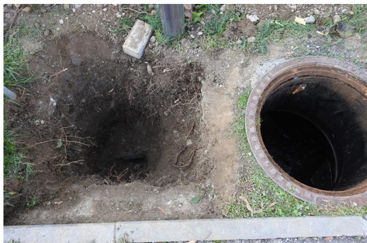
Slika 43: Prikaz pogleda na mesto izvedenega izkopa in lokacijo hidrantnega sistema
