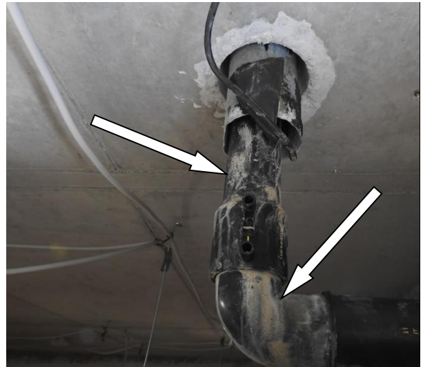
Slika 16: Prikaz sledi precejanja vode preko vgrajene cevi odtoka
