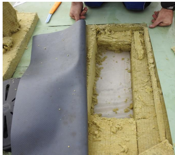
Slika 38: Prikaz pogleda na suho toplotno izolacijo strehe, ob aklimatu
