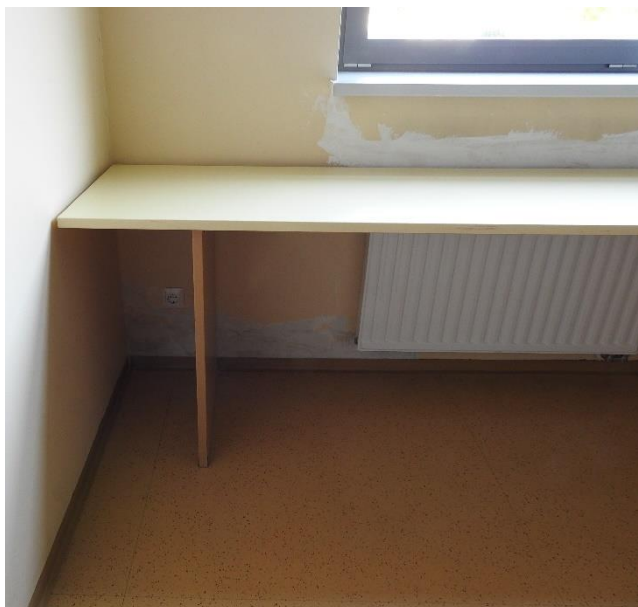
Slika 17: Prikaz sledi vlaženja zidov ob SZ vogalu učilnice Informatika, št. 16
