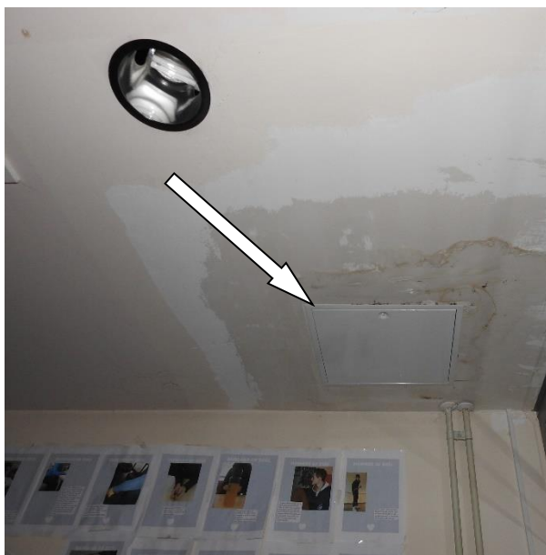
Slika 23: Prikaz dodatno nameščene servisne lopute oz. vratc
