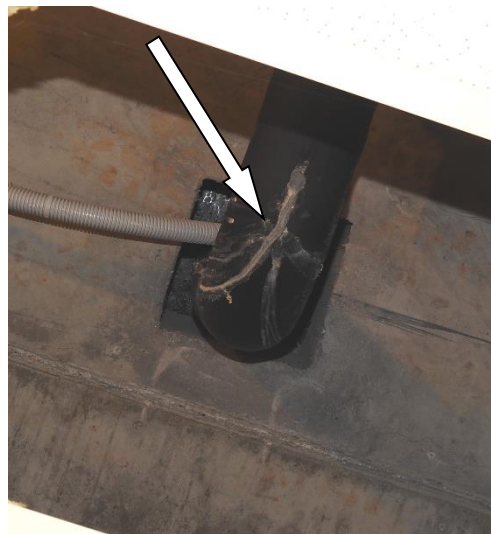
Slika 3: Prikaz izrazitih sledi precejanja na toplotnoizolacijskem ovoju cevi odtoka (desno od 1. okna)
