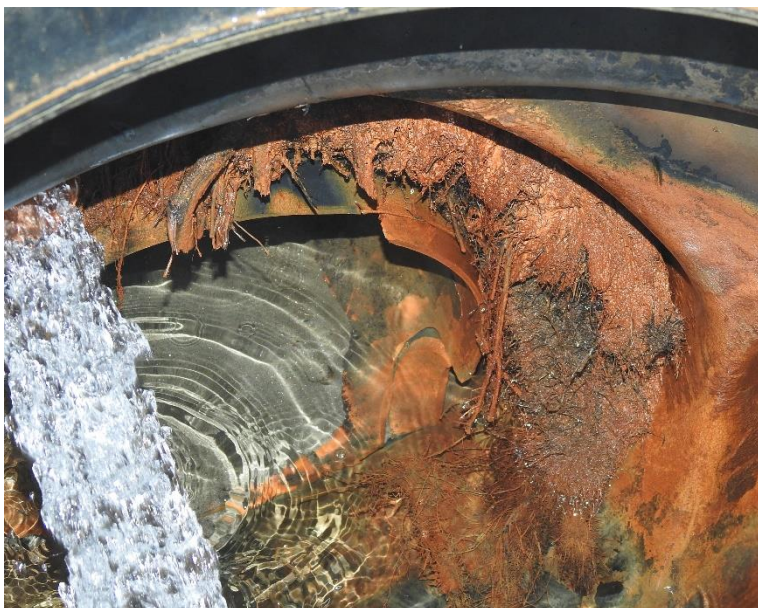
Slika 42: Prikaz popolne zaraščenosti s koreninskim sistemom v predelu oboda vtočne cevi v jašek
