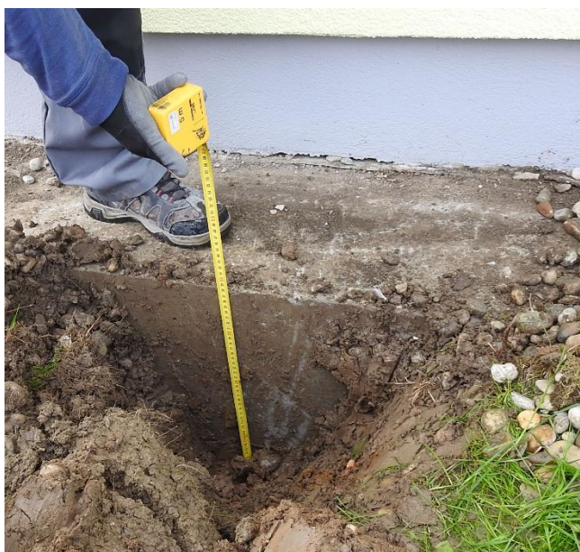
Slika 32: Prikaz pogleda na odkopan del do globine 40 cm, v predelu temeljen plošče ob S fasadi objekta
