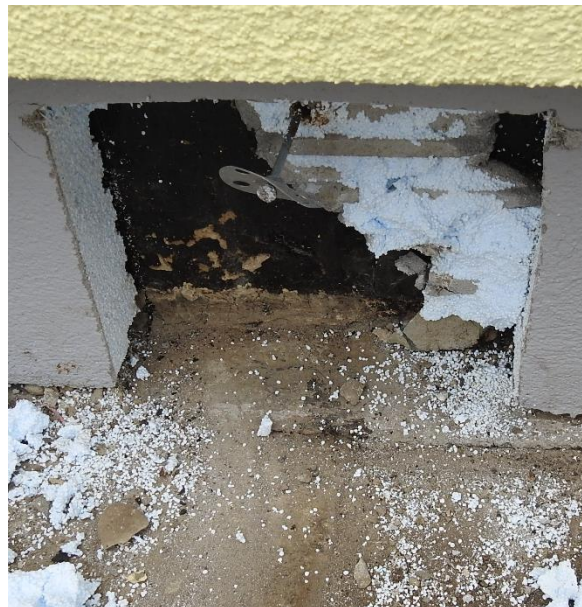
Slika 35: Prikaz pogleda na potek vgrajene hidroizolacije
