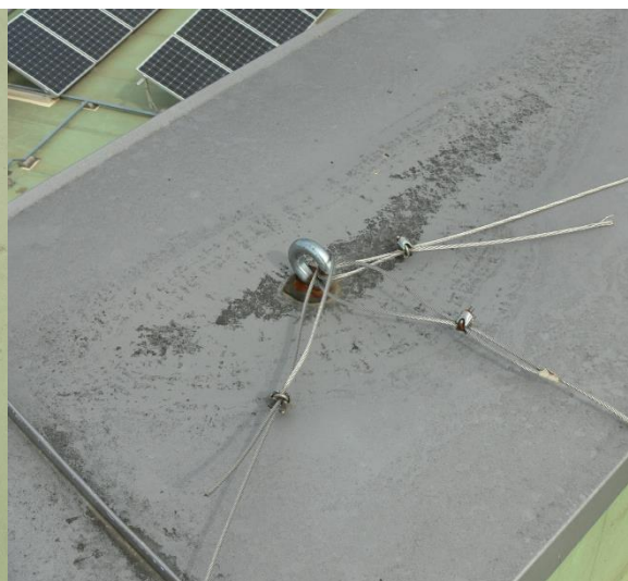
Slika 30: Prikaz pogleda na izvedbo sidranja sončne elektrarne skozi pločevinasto kapo
