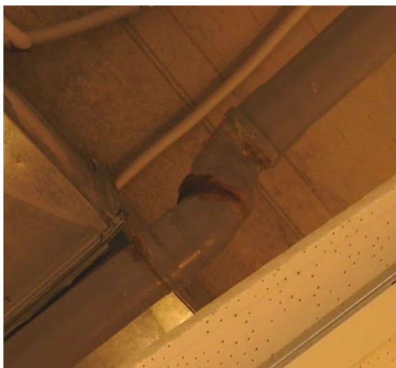
Slika 10: Prikaz sledi precejanja v preteklosti, v predelu vgrajenih PVC kolen
