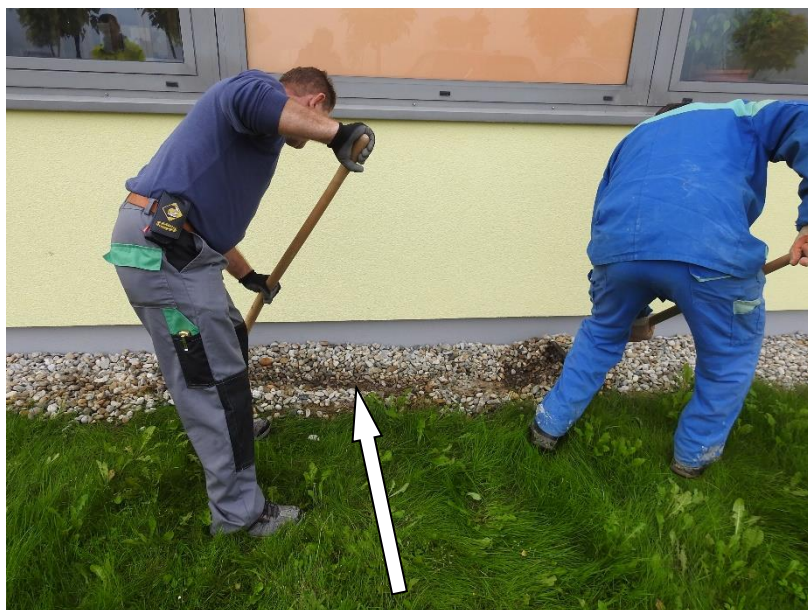
Slika 31: Prikaz lokacije sondažnega mesta z oznako Sonda S1
