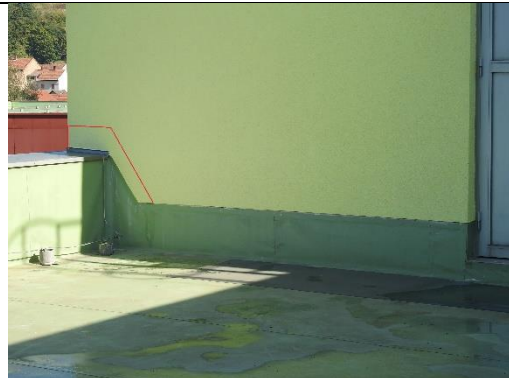
Slika 41: Prikaz linije izvedbe reza v Z fasadi ob SV vogalu manjše nižje ležeče strehe
