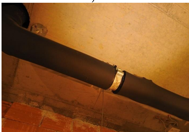
Slika 8: Prikaz ravnega dela vgrajene cevi odtočnika s toplotnoizolacijskim ovojem, kjer ni vidnih sledi precejanja vode
