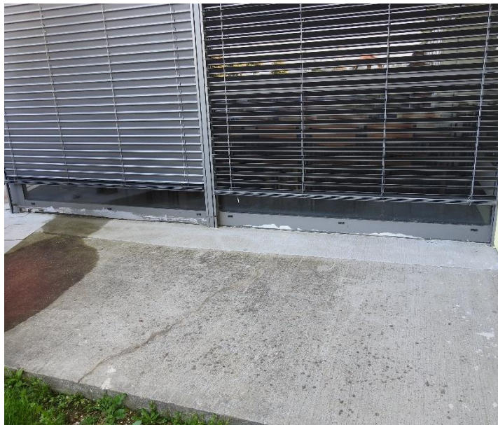
Slika 25: Prikaz pogleda zahodno stran zasteklitve ob SZ vogalu telovadnice
