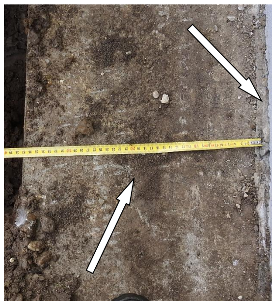
Slika 33: Prikaz pogleda na širino vidnega dela temeljne plošče in širine hidroizolacije, ki sega izpod fasado objekta
